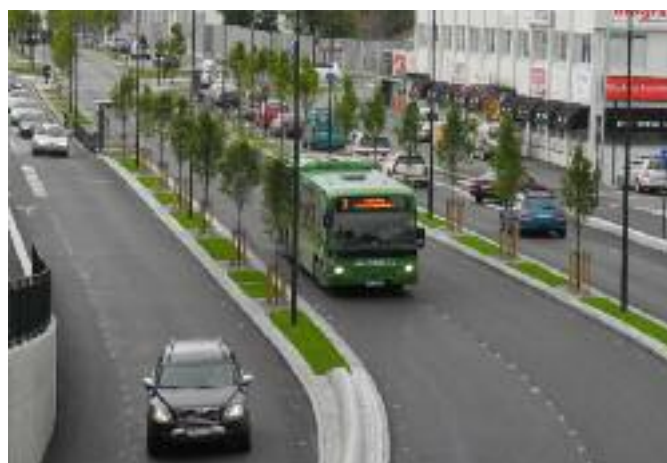
Høystandard bussløsninger med midtstilte, separate bussfelt gir forutsigbar kjøretid og kapasitet på nivå med skinnegående systemer. Stavangers bussvei, hvor første del ble åpnet i 2011, skal utvides til å bli Europas lengste bussveiprosjekt. Foto: Kolumbus.
